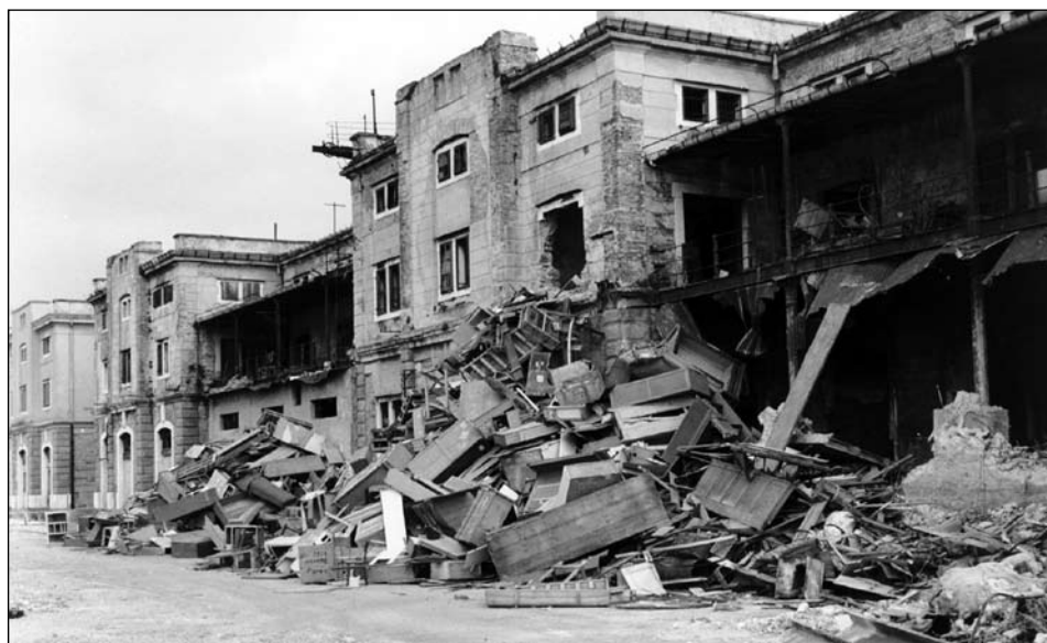
1988, demolizione del magazzino 22 e distruzione di una grande quantità di mobili e cassoni dei profughi nel Porto Vecchio di Trieste (foto pubblicata in: Delbello Piero, Esodo , Istituto Regionale per la Cultura Istriano-Fiumano-Dalmata (I.R.C.I), Artigraficheriva srl, Trieste, 2004).
